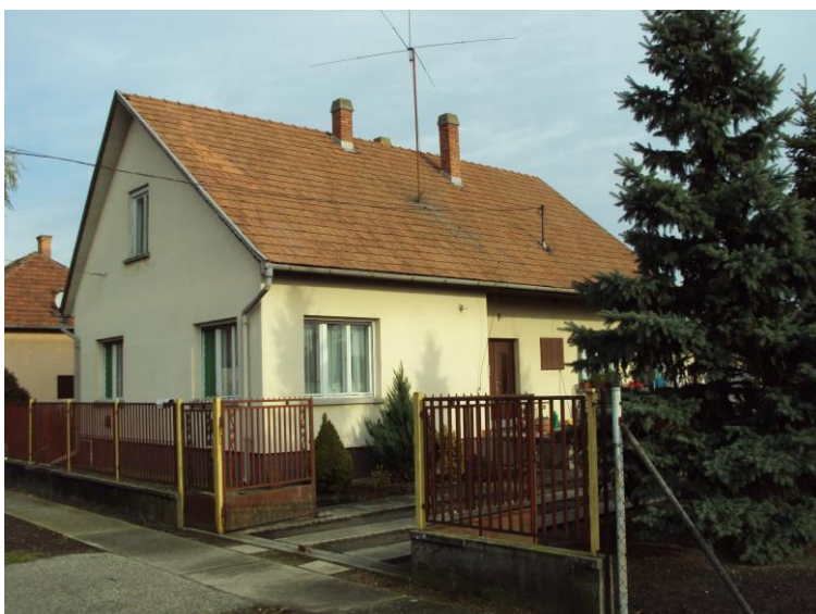
Az 1970-es években épített nyeregtetős ház a Gesztenyesor utcában
