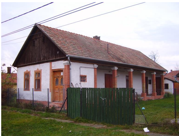
A Csokonai utcában található oszlopsoros régi parasztház.
