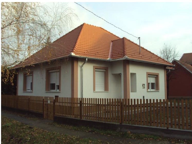
Az 1960-as évek építészetére jellemző, a közelmúltban igényesen felújított sáttortetős ház a Petőfi utcában
